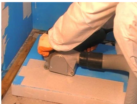
Retrait de peinture sur béton cellulaire
